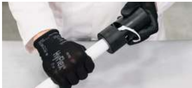
Рис. 29. Резка (труба steelPRES в изоляции из полипропилена).
